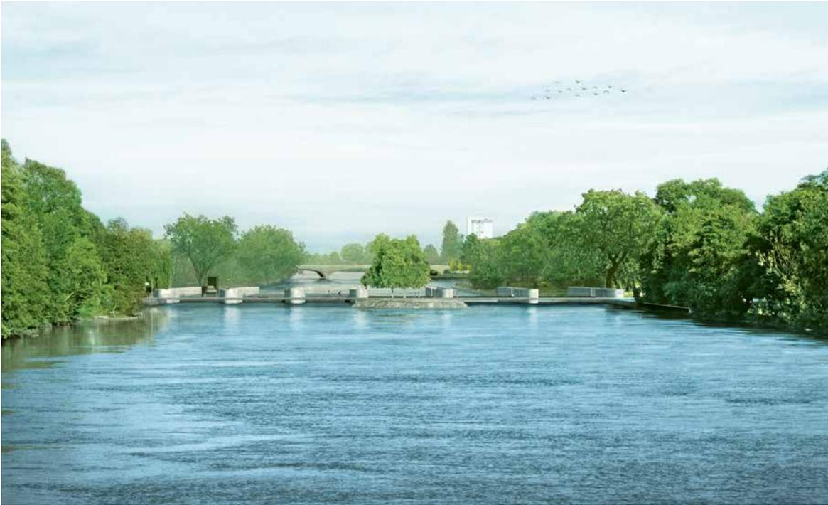
Sicht von der Häsibrücke Richtung Kraftwerk: Das neue Deckelkraftwerk ist deutlich tiefer, kompakter und fügt sich natürlicher in die Umwelt ein. Es verfügt über drei Rohrturbinen, Fischtreppen für den Aufstieg, Vorbereitungen für den Fischabstieg sowie zwei Hochwasserentlastungsklappen.
